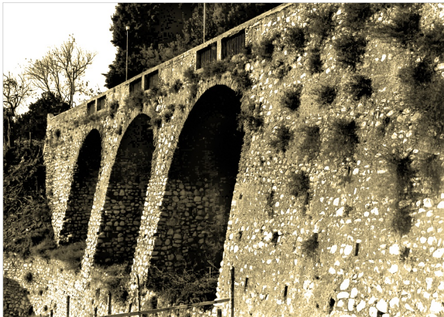
Anoja. Il muro di sostegno per la “piazza del passeggio”, detta passeggiata dell’Olmo, costruito negli anni 1881-1882.
